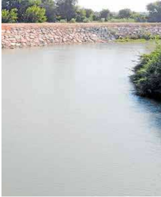
◀ Refuerzo. Los trabajos construyendo muros de escollera en los márgenes del Júcar ya han finalizado en Albalat. LP
